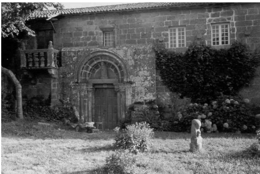
Figura 2: Vista da porta norte da igrexa monástica. Obsérvanse as transformacións feitas no século XVII para o acondicionamento coma vivenda da igrexa.
