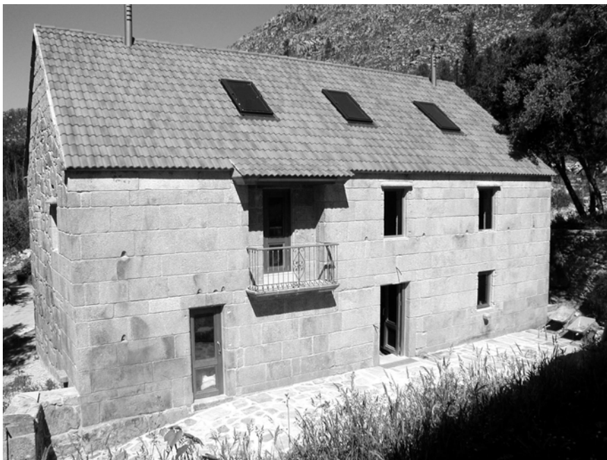
Foto 4: San Cibrán, fachada.
