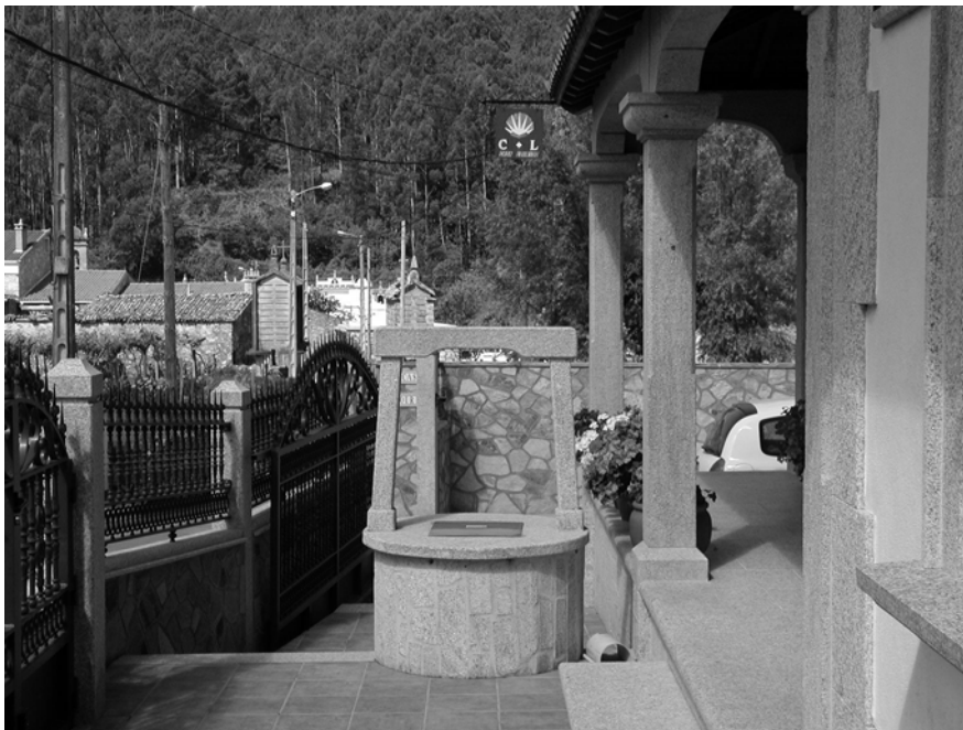
Foto 1: Casa Lourido, antigo pozo totalmente remozado.
