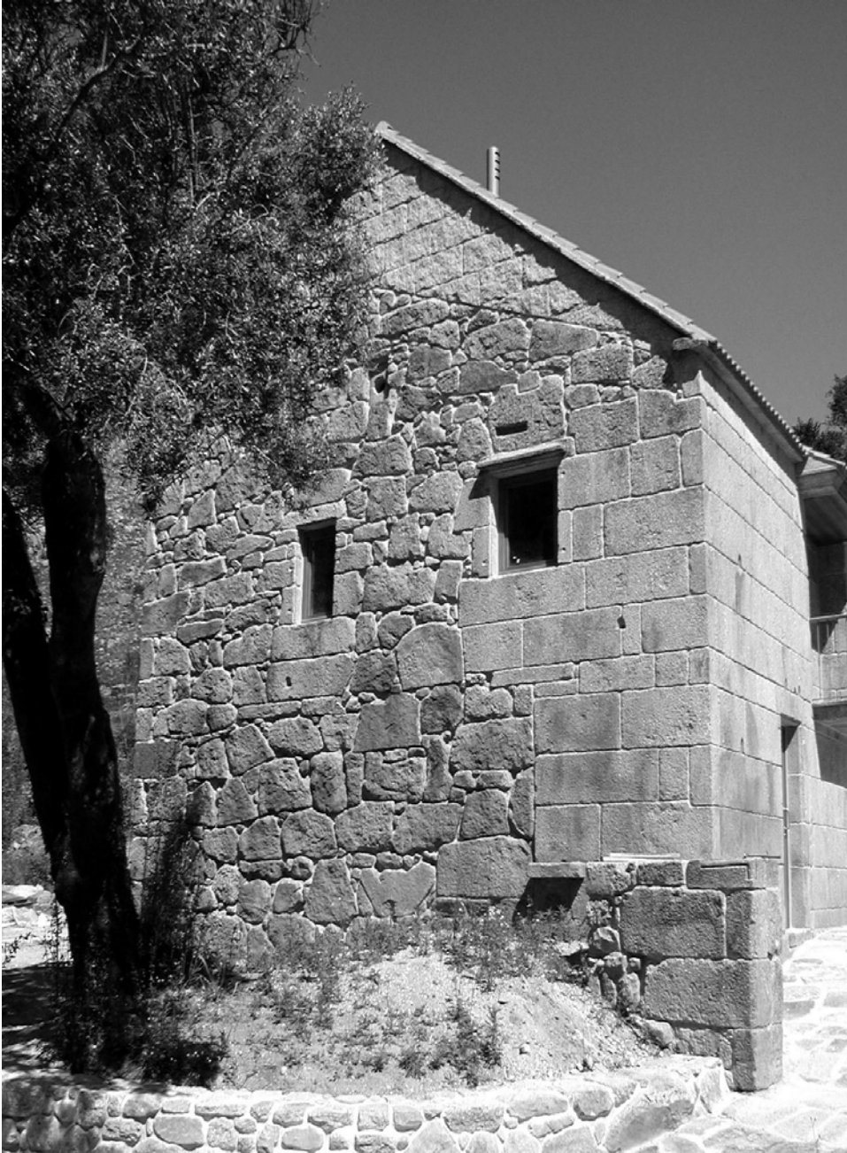
Foto 3: San Cibrán, engadido baixo cuberta onde se aprecia a diferenza de materiais para destacar a non reconstrucción.
