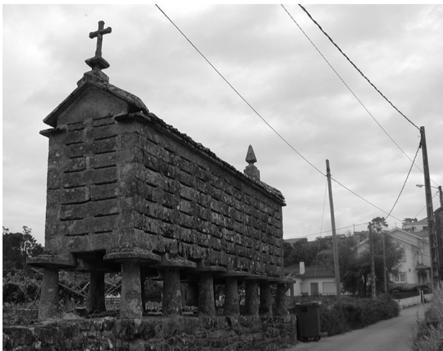
Foto 13: Casa Raúl, cabaceira. Obsérvese o cableado no camiño público.
