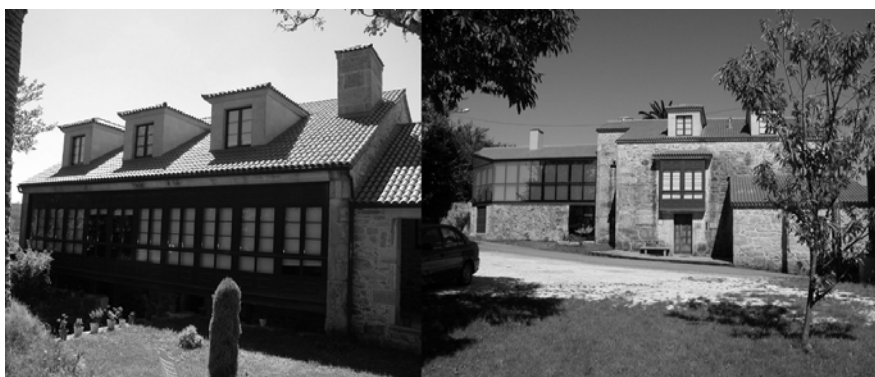
Foto 18: Casa Curiña, fachadas dianteira e traseira, repicadas. Obsérvese a nova cristaleira na dereita e as bufardas na fachada posterior (esquerda).
