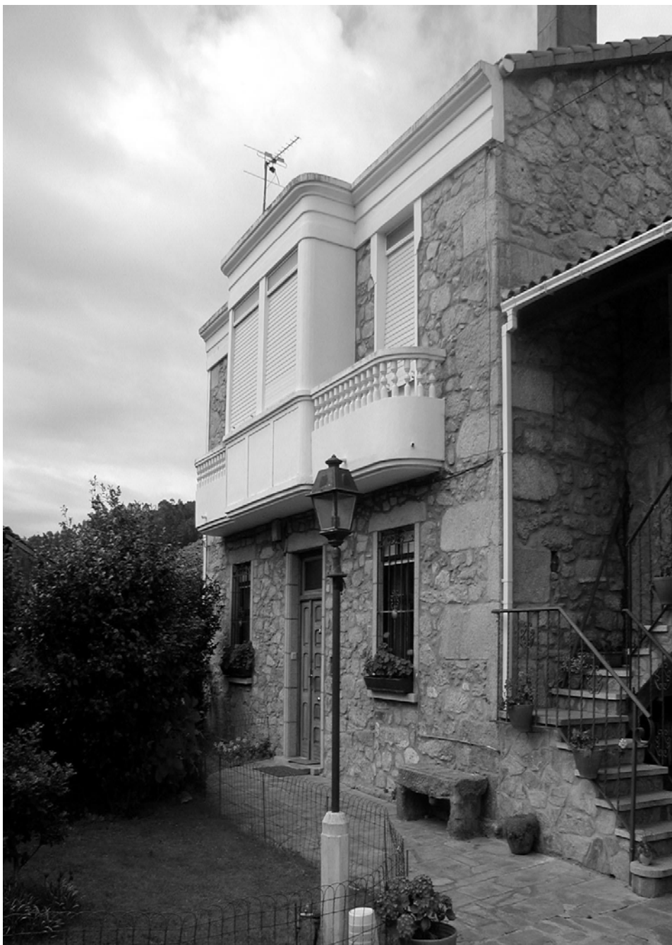
Foto 10: Casa Raúl, fachada.
