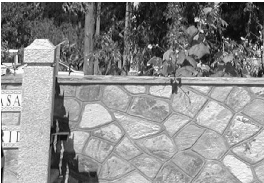
Foto 2: Casa Lourido: detalle onde se aprecia a nova técnica de construción.
