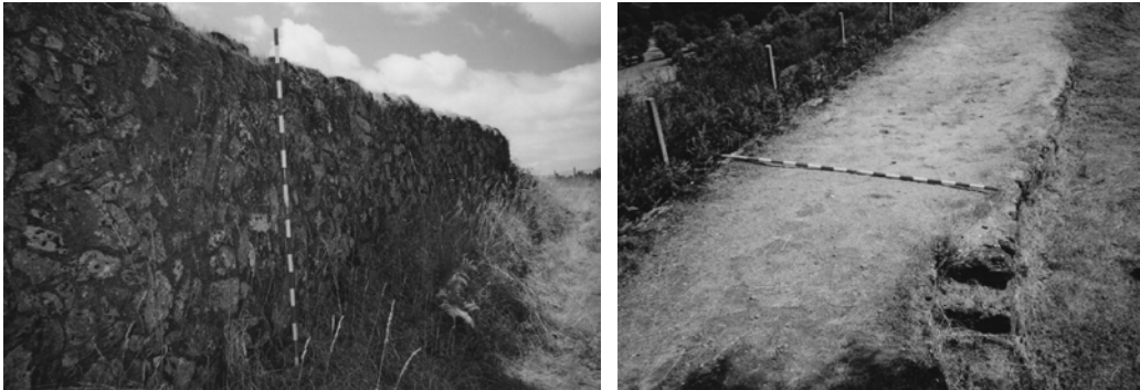
Fig. 36: Cara exterior da muralla de Castromao, consolidada e parte superior da mesma, onde se ve o estreitamento que alberga as escaleiras de acceso, no barrio contiguo ao da Tábula .
