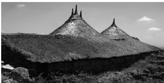
Fig. 18: Cuberta do barrio reconstruído de Sanfins, onde o colmado se moldea dacordo ás formas curvas e rectas.
