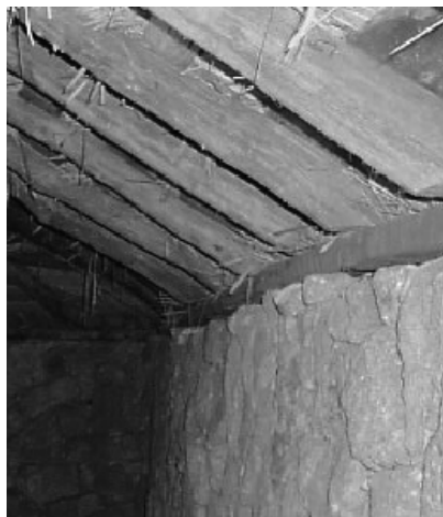
Fig. 5: Apoio da cuberta sobre os muros, na reconstrución de Sanfins.
