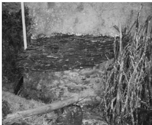
Fig. 31: Forno adosado exteriormente nunha casa de Aranga (A Coruña), con cuberta plana de laxas.
