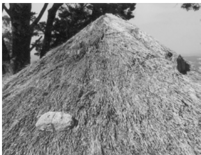
Fig. 10: Sistema de pesos amarrados aplicado a unha das reconstrucións de Santa Tegra.
