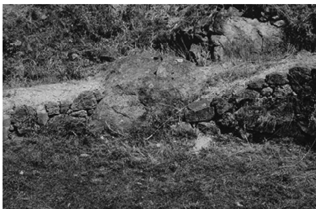
Fig. 4: Aproveitamento dunha rocha para o asentamento do muro dunha estrutura, na vertente oeste de Castromao.
