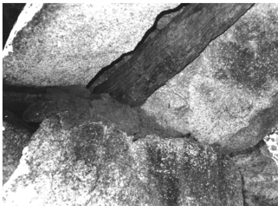
Fig. 6: Lumieira mixta, de pedra e madeira. A mesma entrada ten unha soleira de madeira (Pitões das Júnias, Montalegre).
