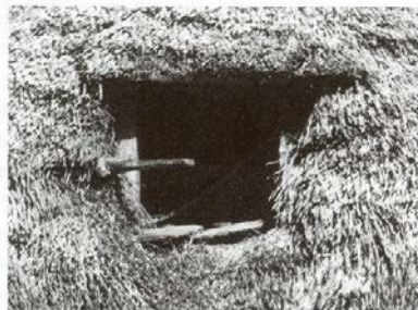
Fig. 8: Abertura para ventilación no colmado dunha palloza (Caamaño Suárez 2003, 165).
