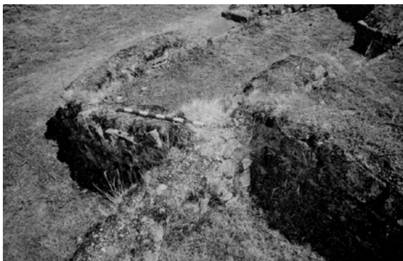
Fig. 22: Unión de muros na estrutura 2, no que o muro do anexo (en primeiro plano), apoia no vestibulo (baixo ó xalón), e este na esquina do corpo principal (á dereita).
