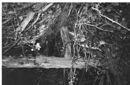
Fig. 17: Sistema de apoio da cuberta nun poste sobre trabe transversal (Forno de Casares, Vereia, Ourense).
