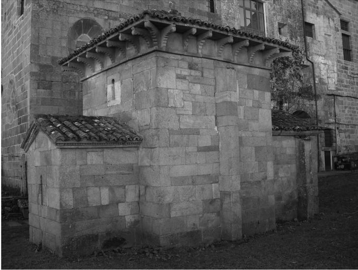
**Fig. 2:** Detalle del engarce de un contrafuerte en el muro (Fotografía del autor, 2007)
