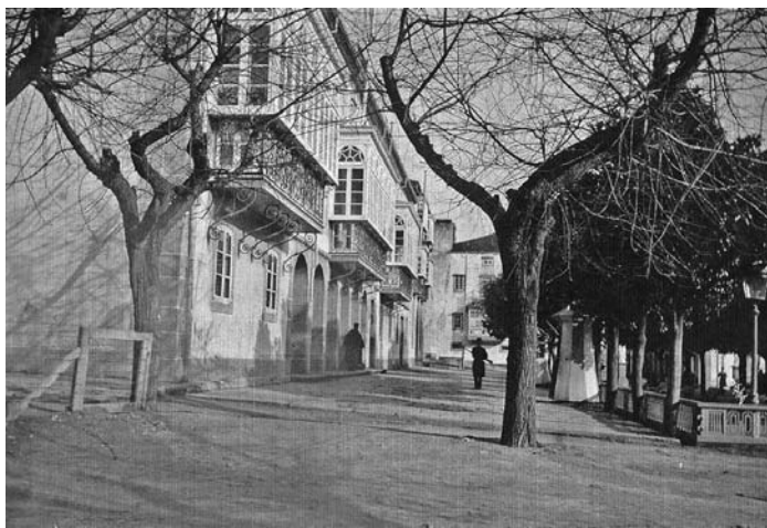
Fig. 15.- Vista de la fachada sur del edificio de Capitanía con la lonja delantera. Foto de hacia 1900.
