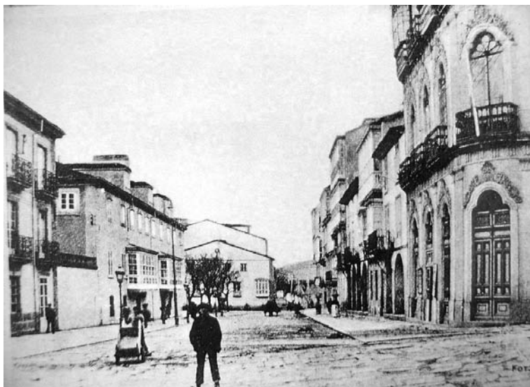
Fig. 19.- Antigua plaza del mercado de comestibles. A la izquierda Capitanía, el patio y el edificio de Estado Mayor. A la derecha las Casas de Salomón ya desaparecidas. Foto de hacia 1900.
