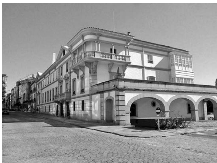
Fig. 1.- Antigua Casa del Comandante General del Departamento de Ferrol (Capitanía) con todas las transformaciones modernas aplicadas sobre las fachadas norte y oeste.
