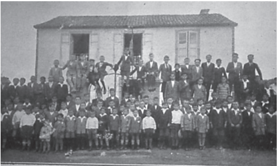
Figura 2. Escuela Fermín Mosquera, Caldas de Rei
