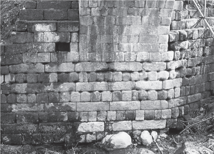
Fig. 12: Hiladas alternas de sillares colocados a soga y tizón, y agujeros para la extracción de los metales del grapado del estribo derecho del Ponte Navea (Ourense) (M. Durán)
