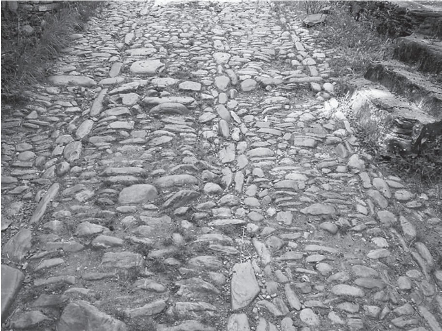
Fig. 18: Pavimento medieval en el acceso al puente de Barxa de Lor (Lugo) (M. Durán)
