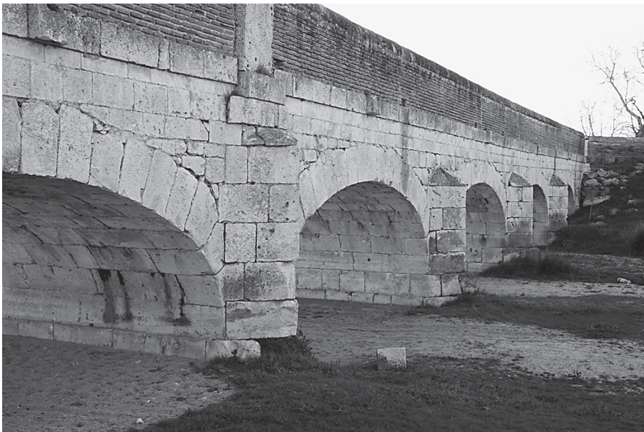
Fig. 26: Alzado aguas arriba de un puente del Camino Real A Galicia antes de Medina del Campo (M. Durán)
