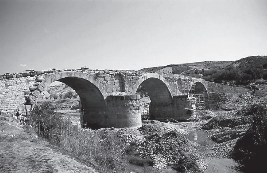
Fig. 9: Alzado aguas debajo de puente sirio-bizantino de Afrin, con espolones circulares (M. Durán)
