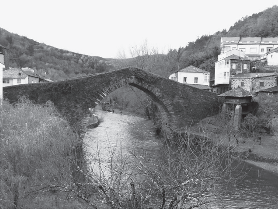
Fig. 21: Vista aguas abajo del puente medieval de Navia de Suarna (Lugo) (M. Durán)
