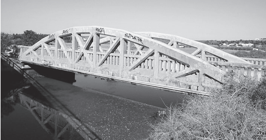
Fig. 29: Puente antiguo de hormigón armado imitando las celosías metálicas, cercano a Portimão (Portugal) (M. Durán)
