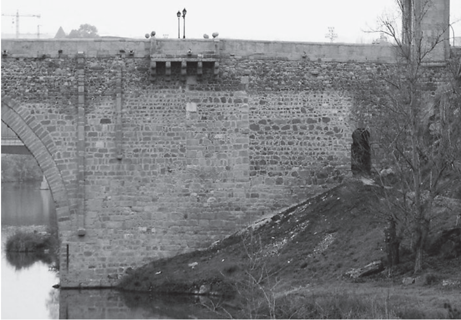
Fig. 16: Dovelas engatilladas de la reconstrucción califal del puente romano de Villa del Río (Córdoba) (M. Durán)
