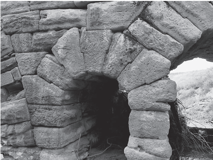
Fig. 16: Dovelas engatilladas de la reconstrucción califal del puente romano de Villa del Río (Córdoba) (M. Durán)
