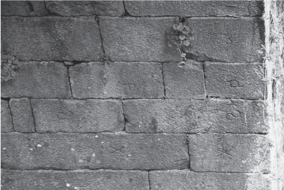
Fig. 19: Marcas de cantero medievales en la bóveda de Ponte Sobreira (Ourense) (M. Durán)
