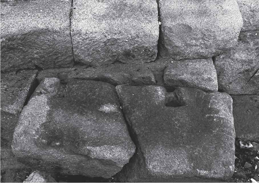
Fig. 12: Hiladas alternas de sillares colocados a soga y tizón, y agujeros para la extracción de los metales del grapado del estribo derecho del Ponte Navea (Ourense) (M. Durán)
