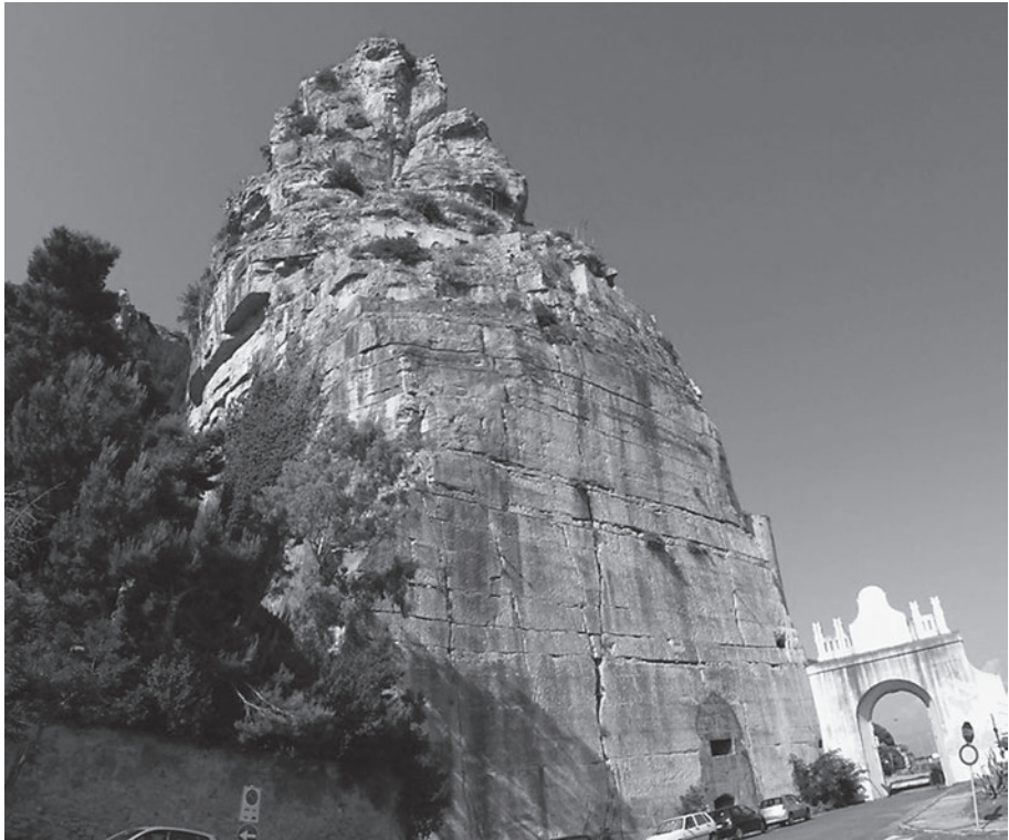
Fig. 6: Desmonte en roca en la Vía Appia en Terracina (M. Durán)
