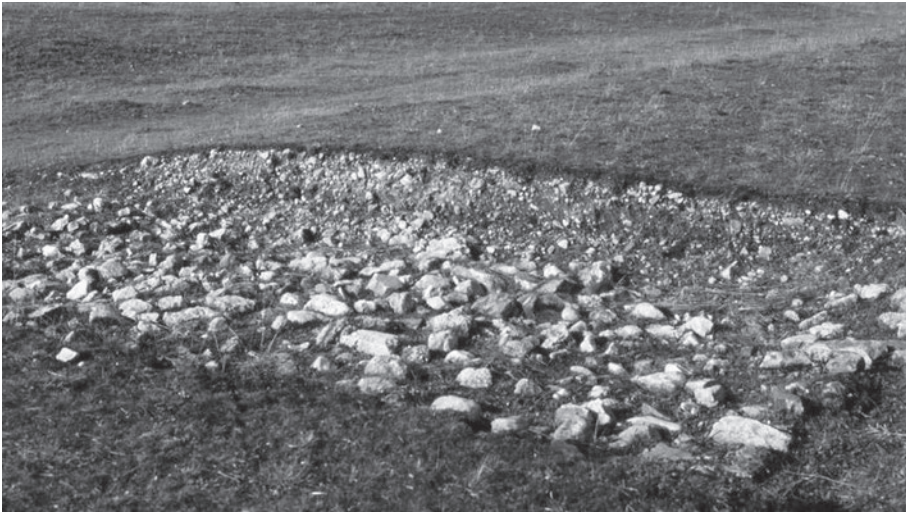
Fig. 5: Corte transversal de la plataforma de la Vía de la Plata cerca de Salamanca (Durán, M.)
