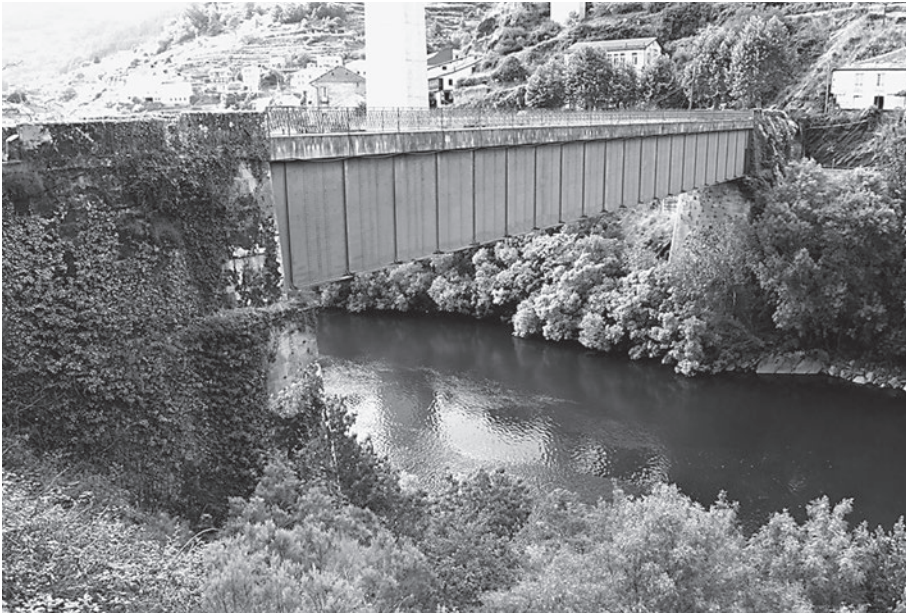
Fig. 28: Puente metálico formado por dos vigas doble T de alma llena en la antigua N-120 en Os Peares (Ourense-Lugo) sobre el río Sil (M. Durán)
