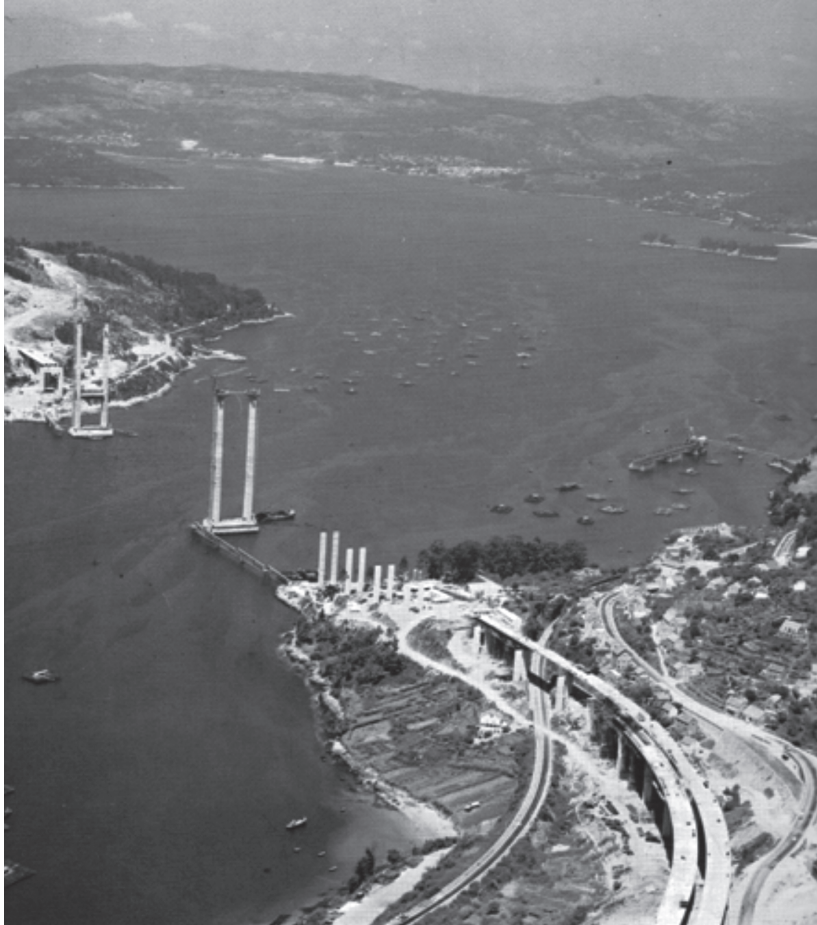
Imaxe 1. Construción da ponte sobre o Estreito de Rande
