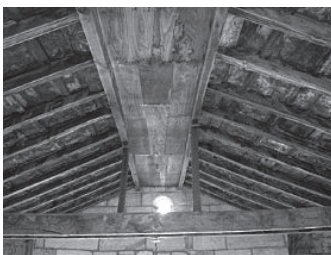
Fig. 14. Armadura do teito da igrexa de Santa Marta.
