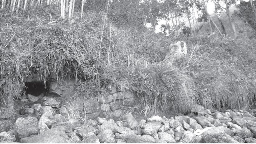
**Fig. 16:** Gran sillar almohadillado esquinale de la edificación caído y muro terminal desaparecido en la actualidad.
