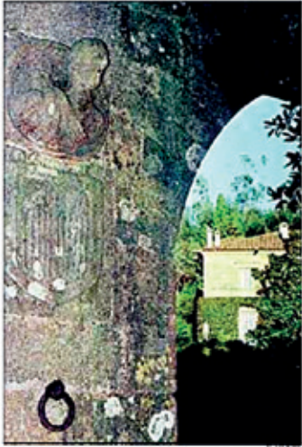
Suposta ruína de Garcia de Casmaño nos límites do paro de Fubiaz
