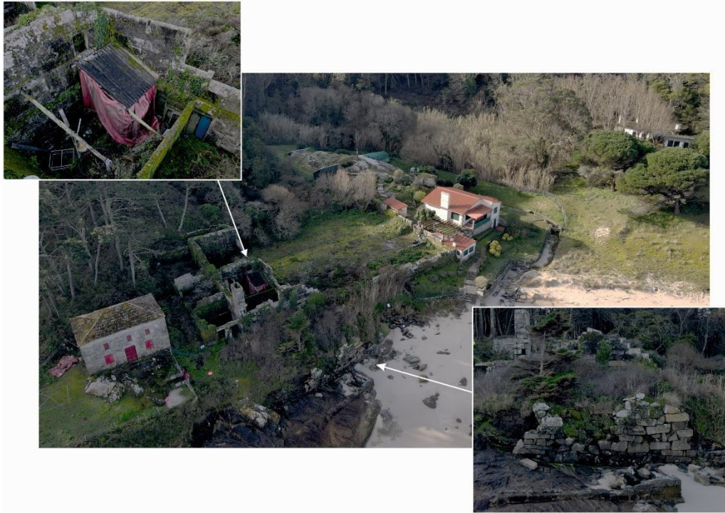
Figura 6. Principais afeccións detectadas na fábrica de salga de San Martiño de Cíes.
