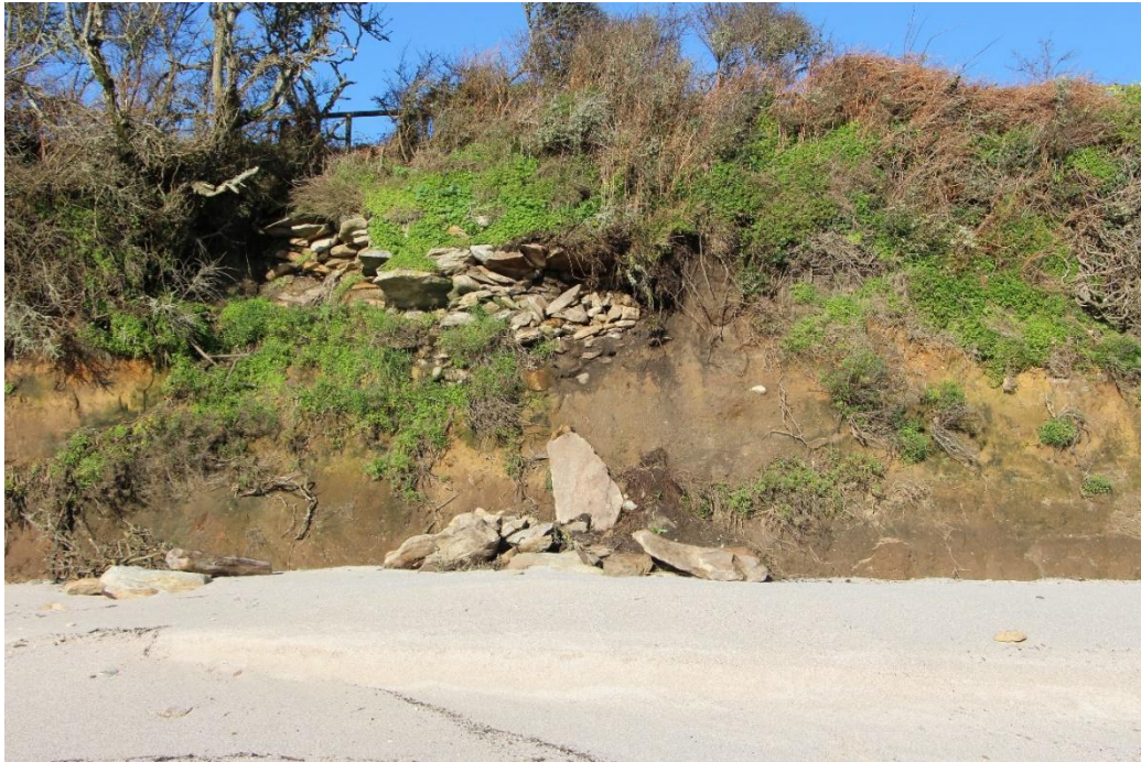
Figura 2. Derrubo de parte da rampla de acceso as fábrica de salga romanas identificadas na prais de Canexol (xaneiro de 2024).
