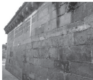
Fig. 10. Muro norte da nave da igrexa de Santa Marta.
