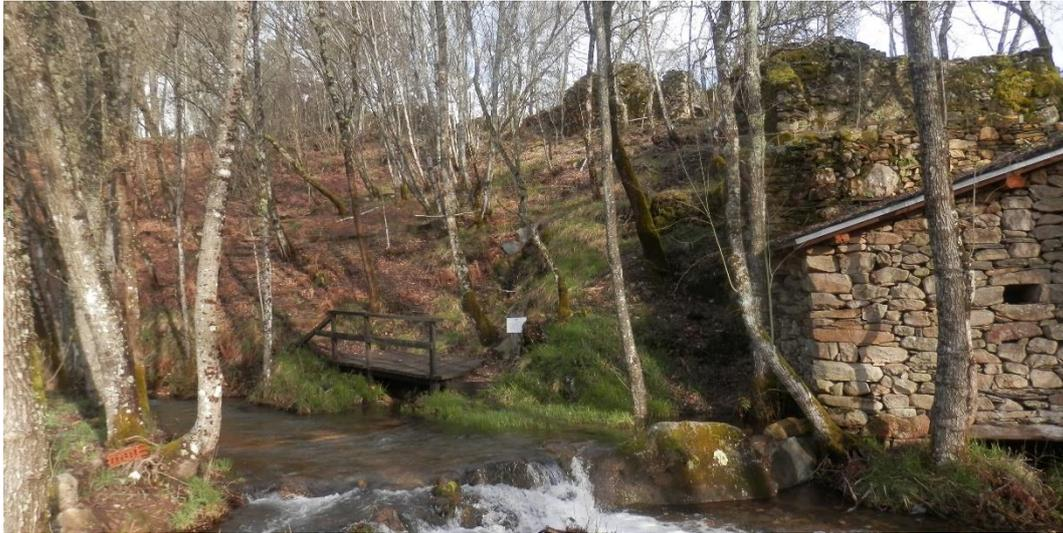
Muíño nº 5: os muros da edificación e a canle conservaban o seu volume e configuración, existindo parte da carpintería exterior (porta de entrada); a cuberta estaba parcialmente derrubada; o forxado intermedio, a configuración do tremiñado e os elementos interiores propios do muíño estaban derrubados ou non existían.
